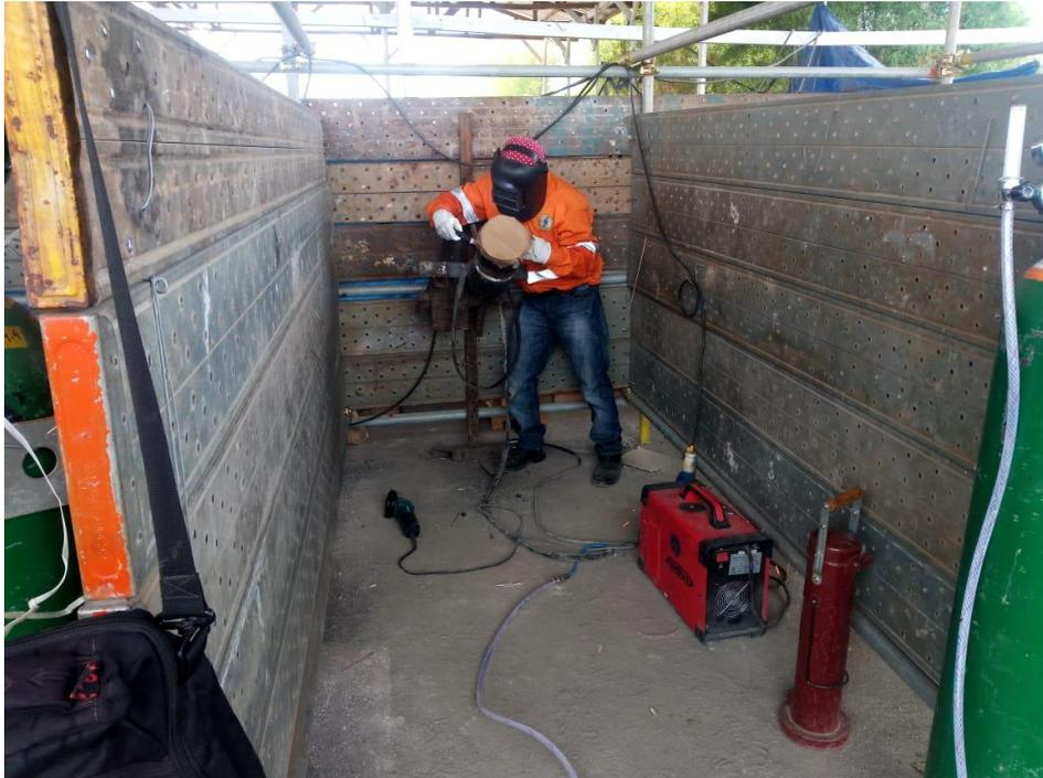
Gambar 3. 3 Proses kombinasi pengelasan posisi 6G
