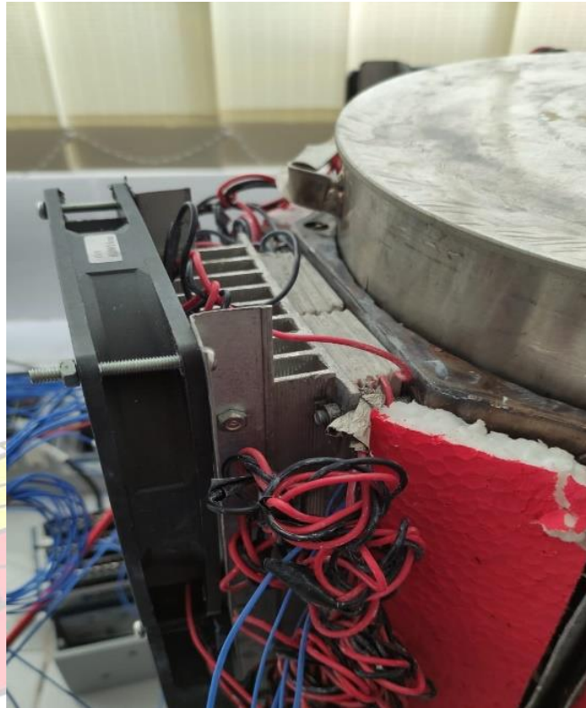
Gambar B3: Pemasangan TEG
