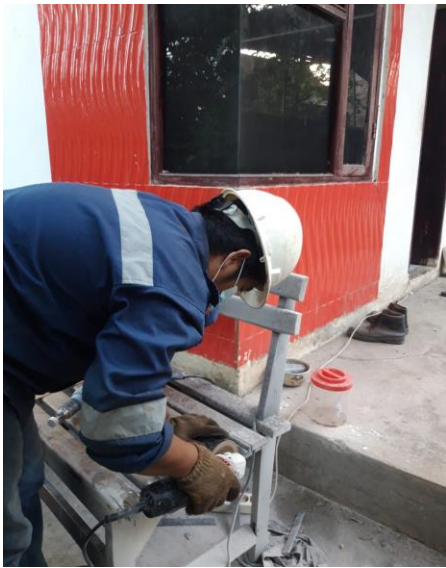
MEMOTONG MATERIAL KOMPOSIT SESUAI STANDAR SPESIMEN UJI
