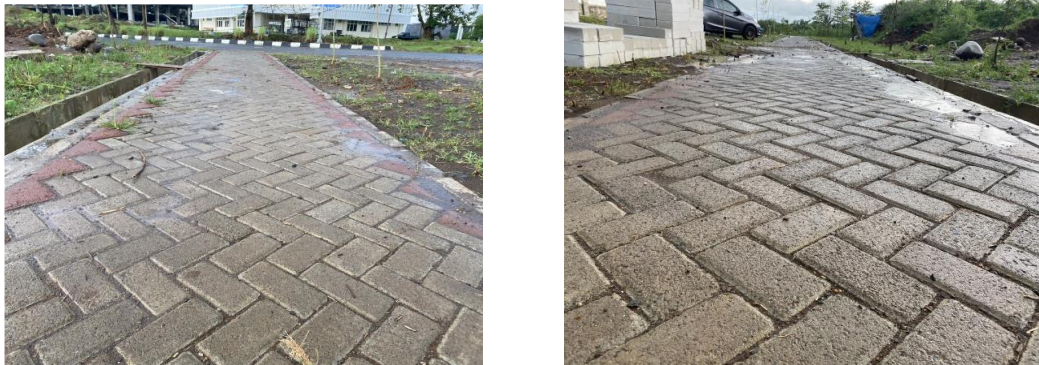
Gambar. 1 Aplikasi Penggunaan Paving block Di Lapangan
