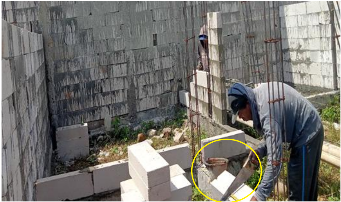
Peralatan yang digunakan oleh tukang berupa gergaji, meteran dan ember
