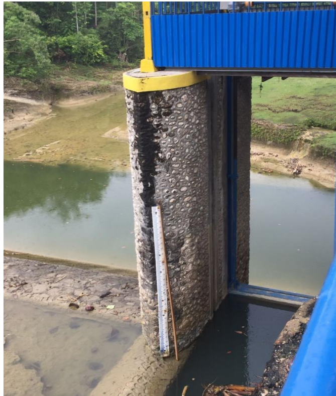
Gambar 9. Mistar ukur yang tidak terbaca
