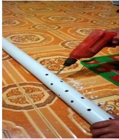
Gambar L-4. Proses pelubangan pipa dengan menggunakan bor listrik.
