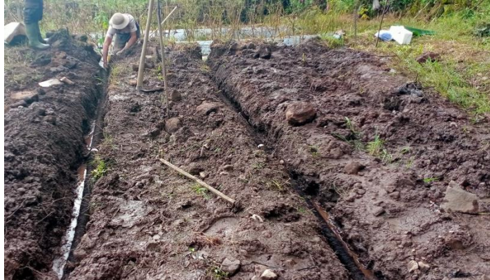
Gambar L-7. Proses peletakan pipa drainase.
