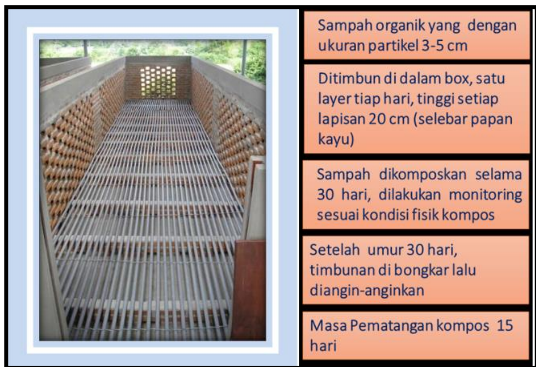
Gambar 0.2. Alur kerja boks bata berongga (Sumber: Buku Petunjuk Teknis TPS 3R, 2017)
