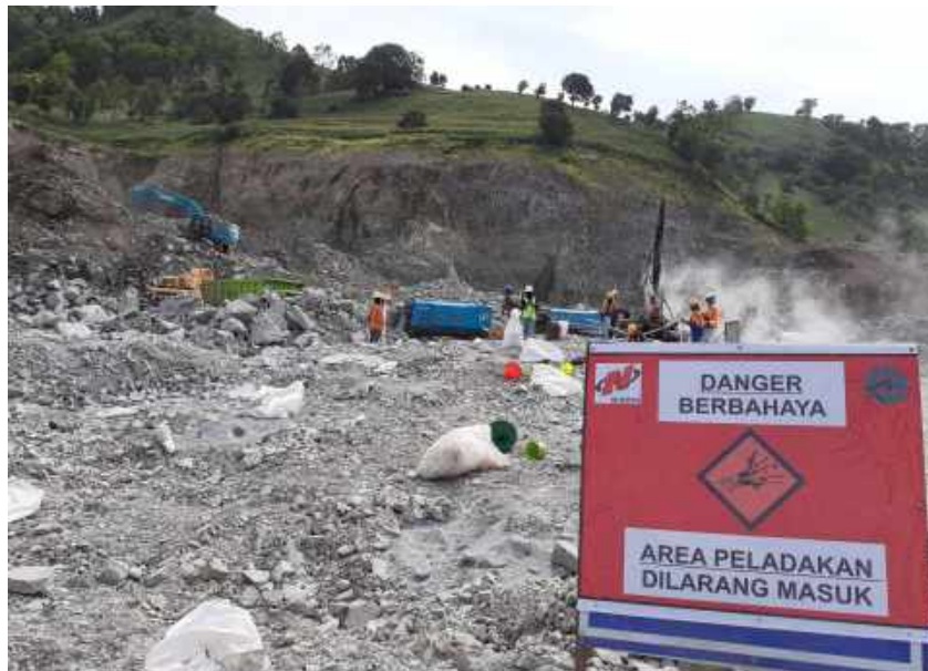
Pekerjaan High Risk berupa Drilling dan Blasting (Pengeboran dan Peledakan)
