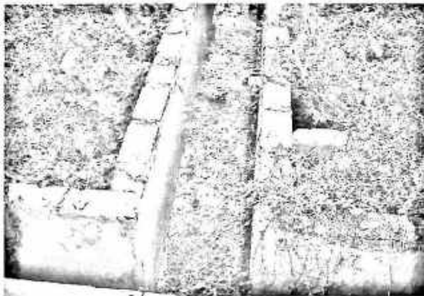
Gambar 9. Drainase Terbuka pada Tapak.
