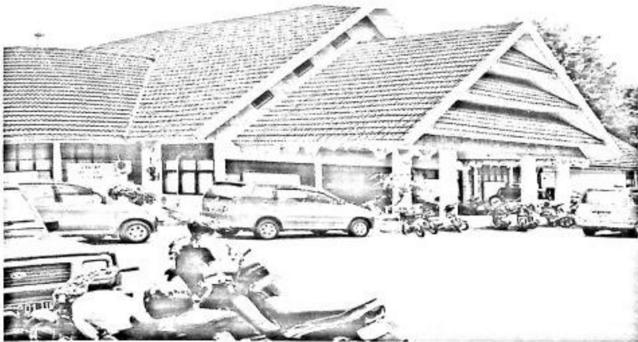
Kondisi pekarangan dan tempat parkir pada Unit Pelayanan Terpadu Perizinan Kabupaten Bone
