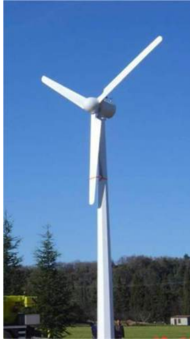
Gambar 2.2 Jenis turbin angin sumbu horizontal ( Sumber : https://docplayer.info/51860099-Plagiat-merupakan-tindakan-tidak-terpuji.html )
