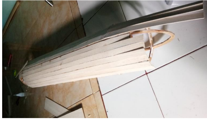
Pemasangan kulit lambung kapal
