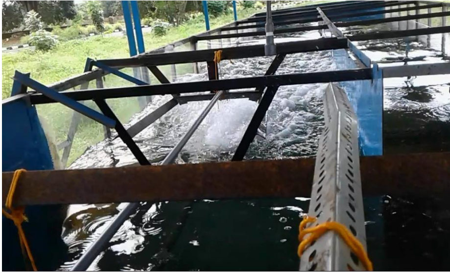
Gambar aliran fluida yang disebabkan oleh putaran propeller
