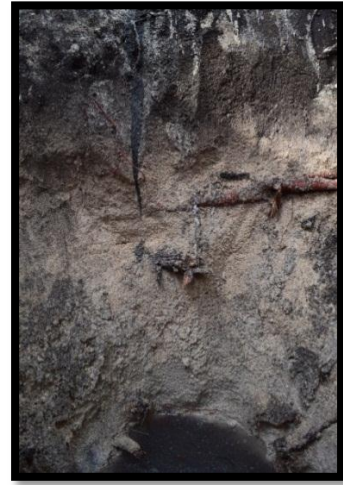
Dinding galian Stasiun C
