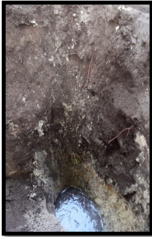
Dinding galian Stasiun A
