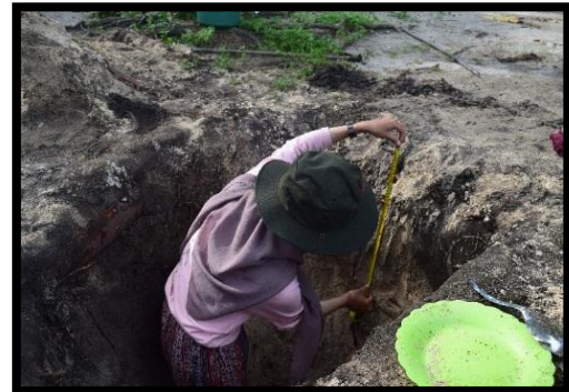
Pengukuran dinding galian
