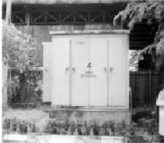
Gambar 2 11 Gardu Tipe Beton (PLN Buku 4, Standar Konstruksi Gardu Distribusi dan Gardu Hubung Tenaga Listrik, 2010)
