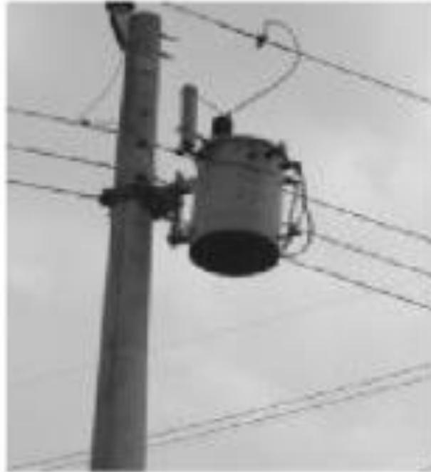
Gambar 2 10 Gardu Tipe Cantol (PLN Buku 4, Standar Konstruksi Gardu Distribusi dan Gardu Hubung Tenaga Listrik, 2010)
