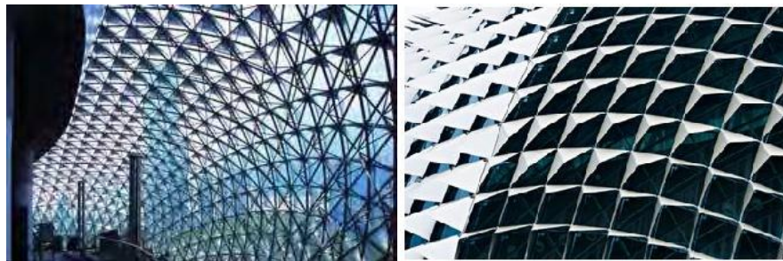
Gambar 35. Cladding pada Esplanade
