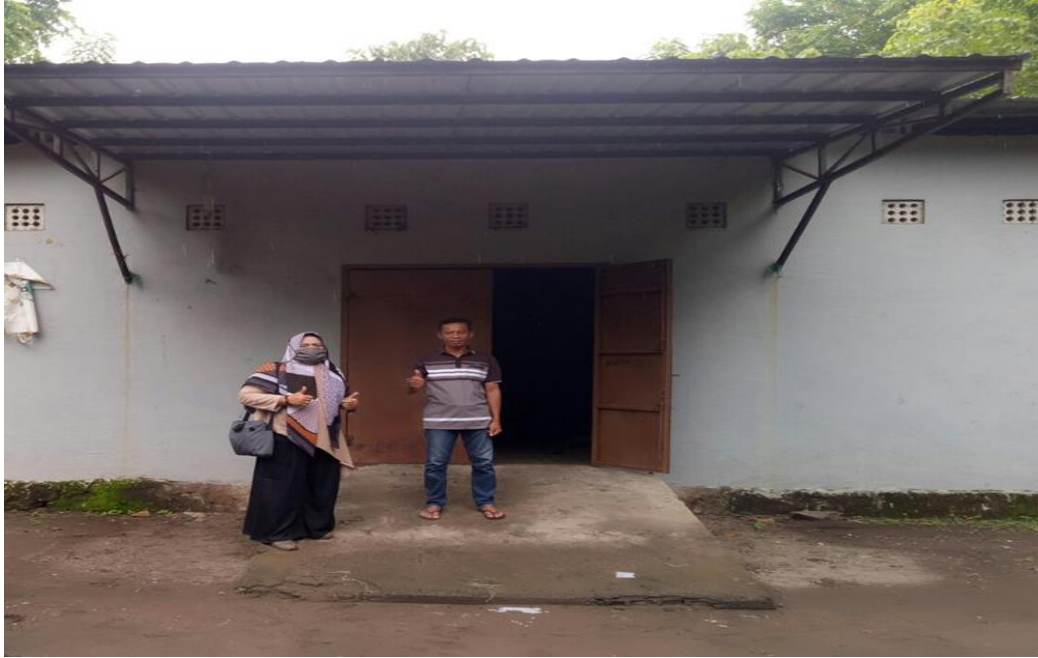
Lanjutan: Gudang Penyimpanan Rumput Laut di Desa Ujungbaji ,Kecamatan Sanrobone , Kabupaten Takalar.
