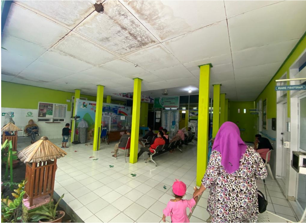
Foto Kondisi Ruang Tunggu
