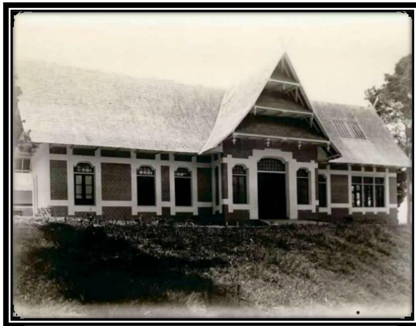
Foto 1. Bangunan Bekas Landschapsziekenhuis 1910 (Sumber: Dhamil, 2019)
