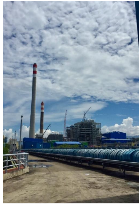
PLTU Barru Sisi Belakang
