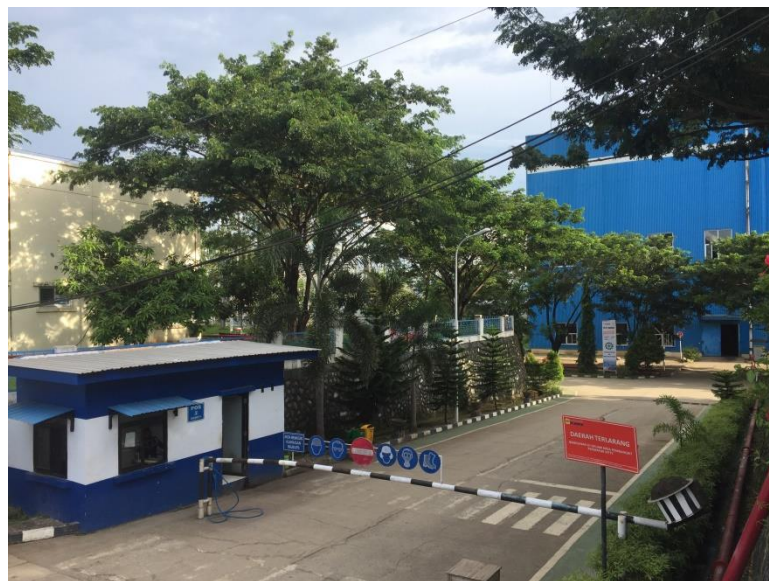
PLTU Barru Sebelum Memasuki Area Lapangan
