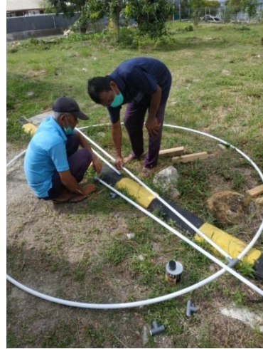
Pembuatan aerasi menggunakan pipa PVC
