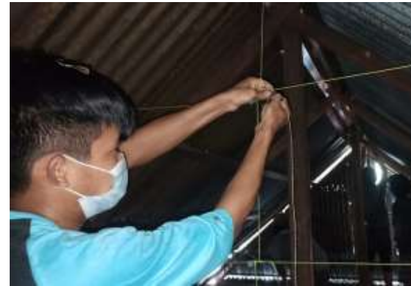
Gambar Pemasangan Sensor
