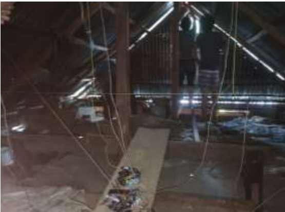
Gambar Pemasangan Sensor
