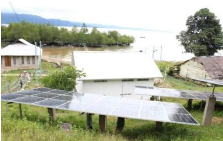
Gambar 6. Pemasangan Panel PV. (Sumber : Fahrul Adi Putra 2015)
