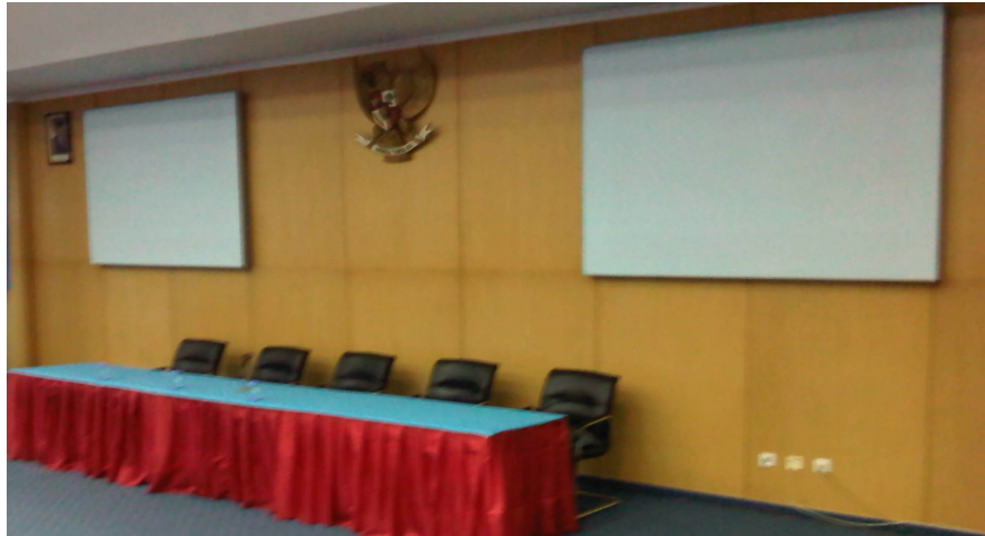
Gambar 57. Dinding dengan lapisan plywood .
