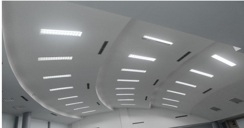
Gambar 37. Plafon menggunakan material dari gypsum.
