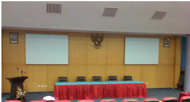
Gambar 39. Dinding depan menggunakan material plywood .
