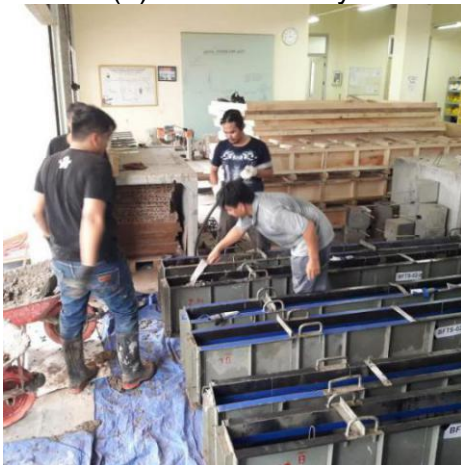
(c) Penuangan beton ke bekisting
