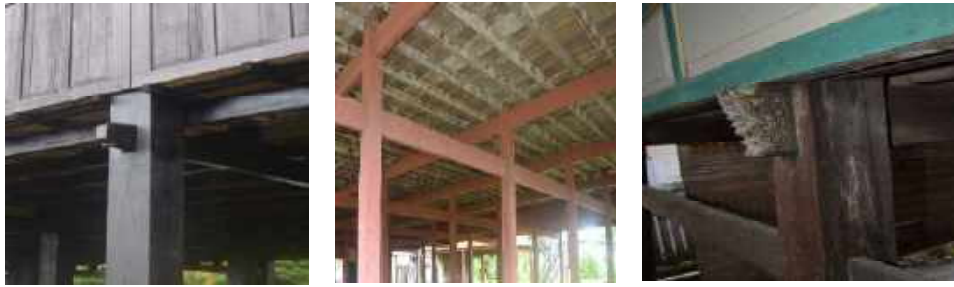
Gambar 4.15. Konstruksi Lantai Pattolo riawa , arateng dan tinebba Sumber: Foto Survei, 2017
