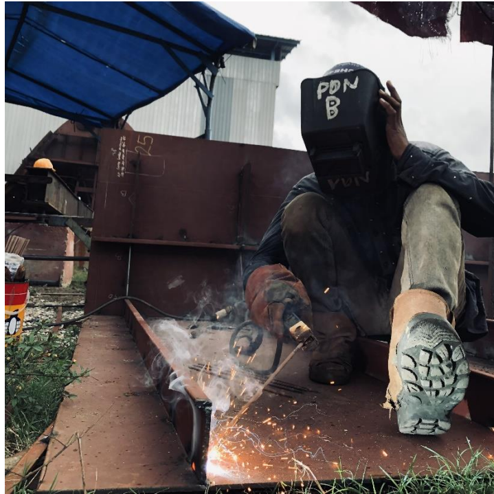
Proses Pengelasan SMAW
