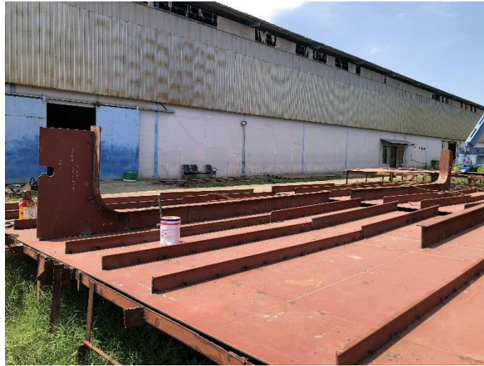
Proses Perakitan Sub-blok
