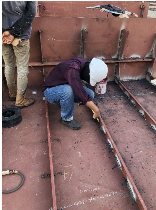
Pengukuran Hasil Pengelasan
