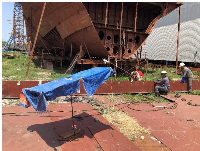
Proses Penyambungan Panel
