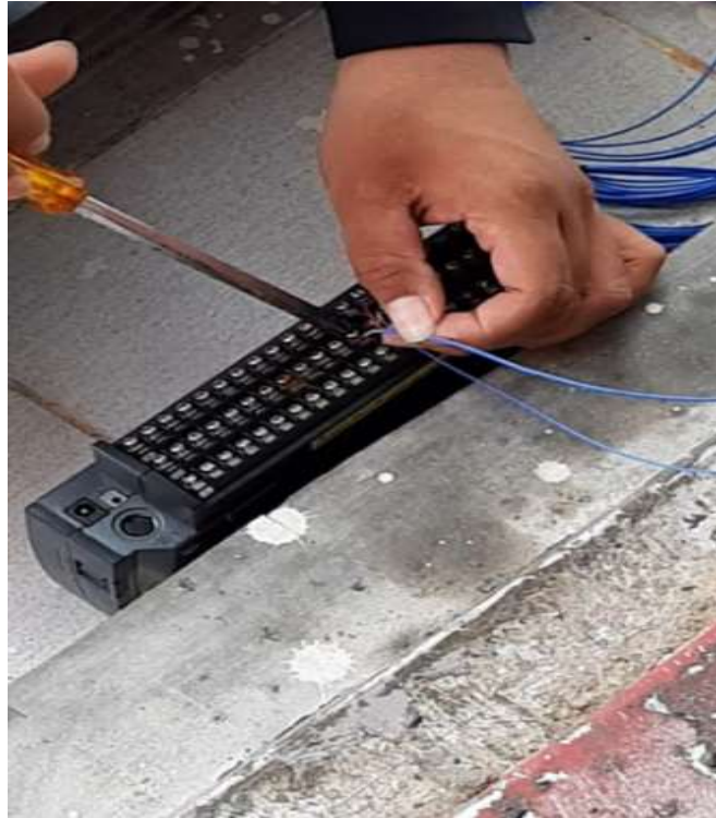
Gambar 3. Pemasangan Kabel Termokopel pada Data Logger
