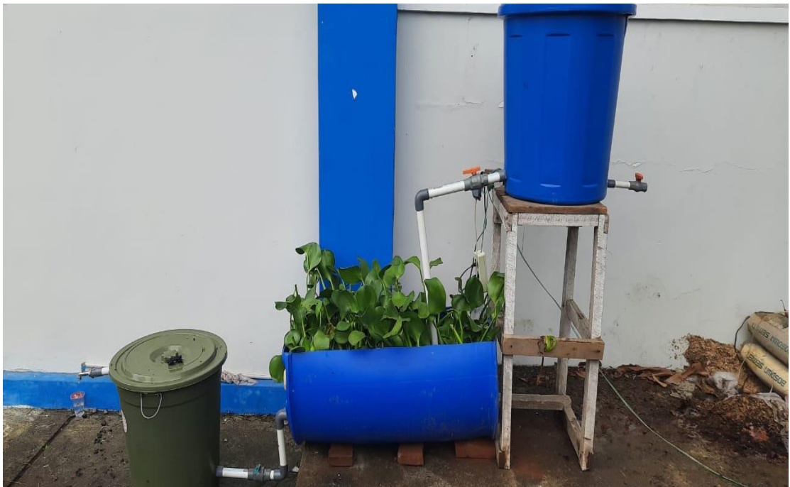
Reaktor fitoremediasi dan filtrasi yang sudah jadi
