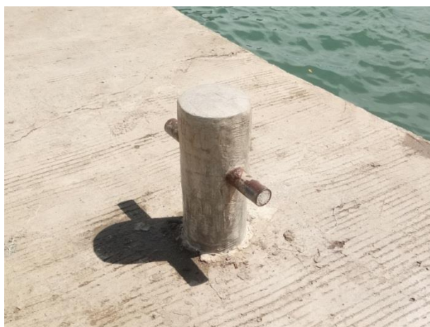
Gambar 4. Mooring dolphin yang ada di PPI Kajang
