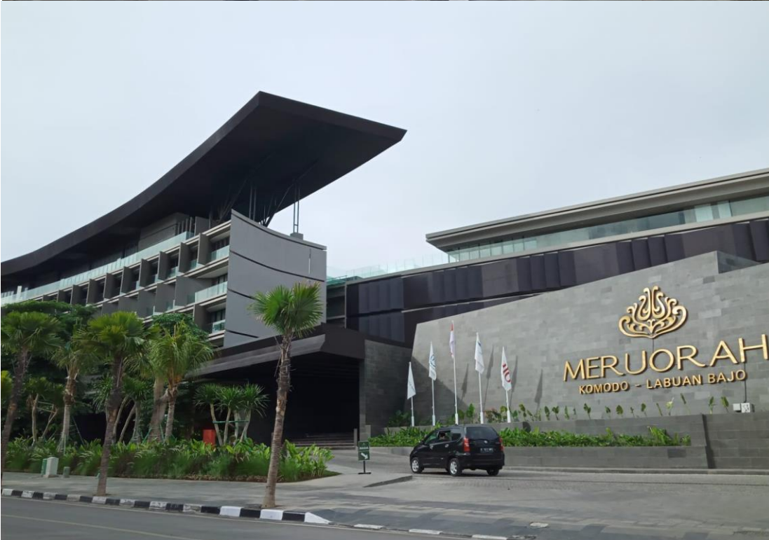
Pembangunan infrastruktur dalam mewujudkan wisata premium hotel dan pusat perbelanjaan marina wilayah kampung ujung yang sudah diresmikan pada tahun 2020 oleh Presiden RI
