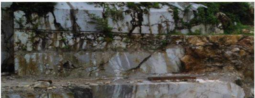
Lokasi kuari 1 pada level 1 hingga level 3.
