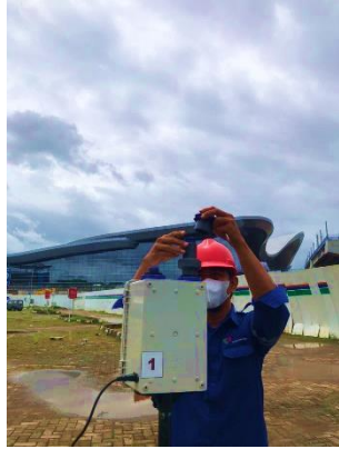
Gambar 1 Pemasangan alat HVAS
