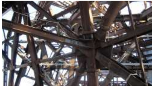
Gambar 15. Koneksi pada elemen diagrid
