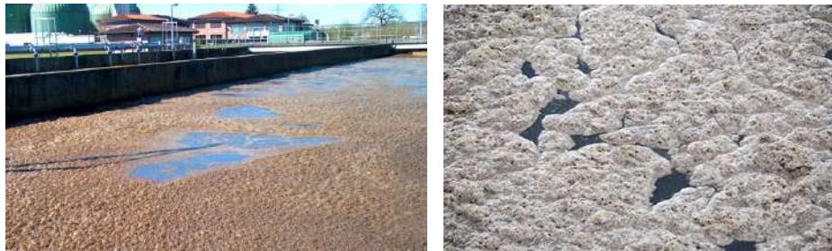
Gambar 4. Bulking pada pengolahan sekunder
