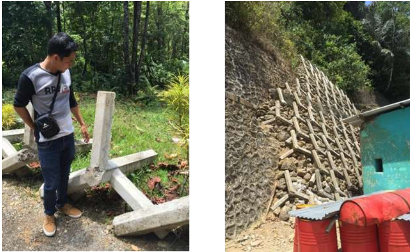
Gambar 2. Perkuatan lereng dengan metode blok
