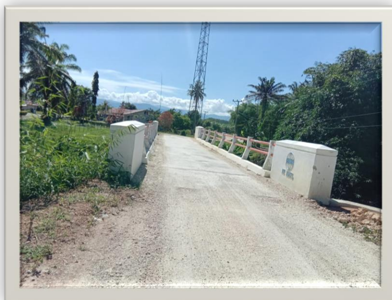
Program CSR PT UWTL 2020 Perbaikan Jembatan Penghubung Antar Desa Balanti dan Desa Kasano
