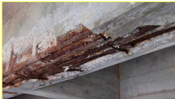
Gambar 1. Kerusakan struktur beton akibat korosi pada tulangan memanjang dan geser
