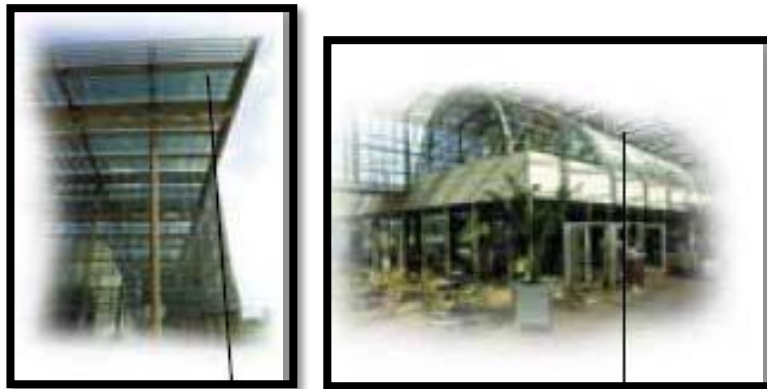
Gambar PV sebagai Penutup Atrium dan Kanopi
