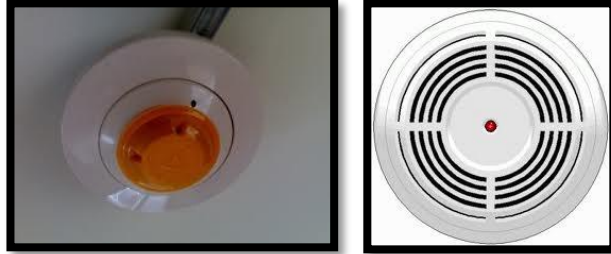
Gambar 48 Detektot Asap dan Detektor Panas
