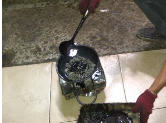
Gambar 23. Pencampuran Aspal dengan Agregat
