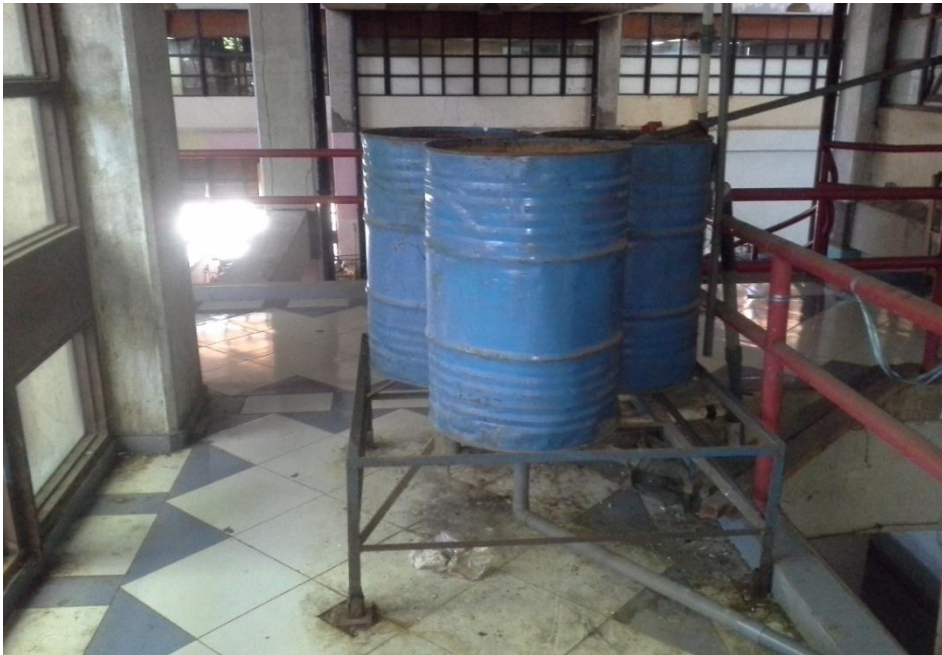
Gambar 9 tanki penampungan atas
