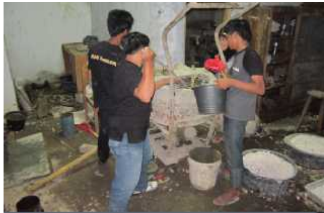
Proses penuangan bahan penyusun beton kedalam molen
