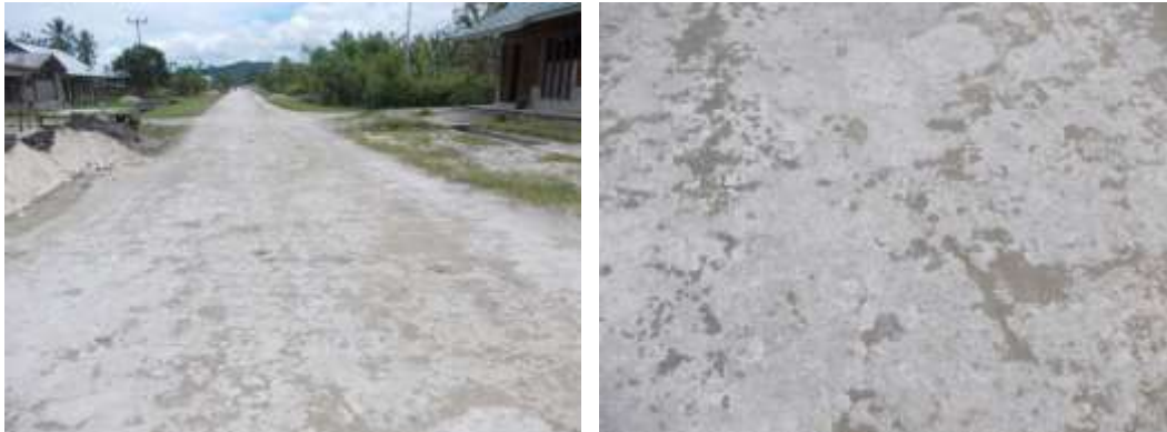
Gambar 1. Ruas jalan di Kabupaten Jayapura, Jalan Besum
